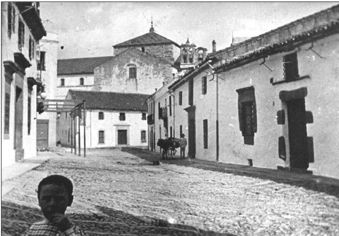
Foto de la Calle Jesús de Pozoblanco en 1903. La casa al fondo a la derecha, con el borrico cargado, era el nº22, donde sucedieron los hechos el 28 de septiembre de 1902. Enfrente estaba el café Casino, recién inaugurado, de cuya fachada sobresalen los postes donde se colocaban los toldos del establecimiento para los días de lluvia o de sol, sobre todo en verano. (Foto proporcionada por D. José Luis González Peralbo, a quien agradecemos nos la haya facilitado, así como sus indicaciones).
